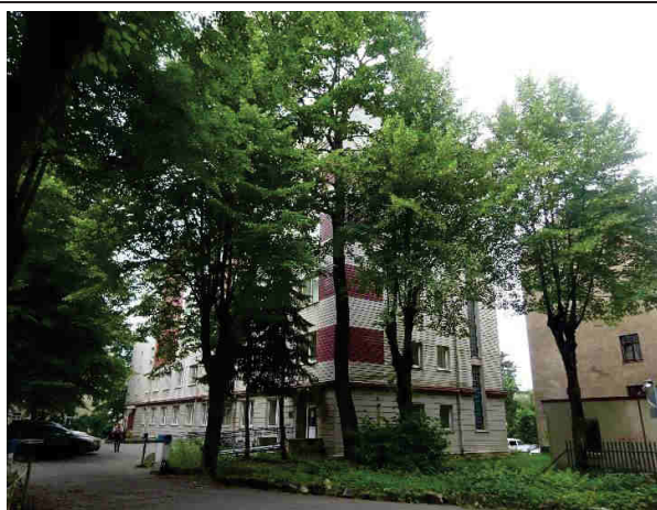
Skats uz ēku lit.nr.025 no iebrauktuves puses
