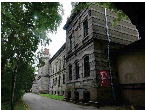
Skats uz ēku lit.nr.001 no iebrauktuves puses
